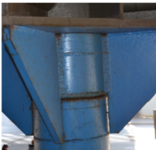
Obr. 6 Neutěsněné či jinak chráněné spáry
