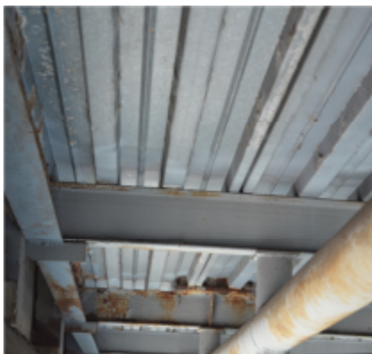
Obr. 18 Nenatřený pozinkovaný trapézový plech
