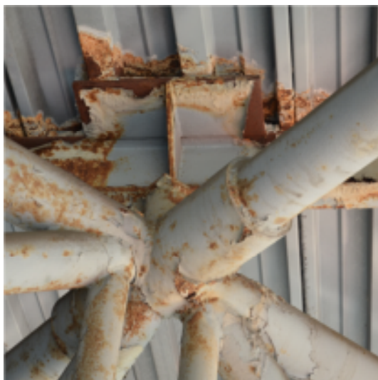
Obr. 15 Uložení stropní konstrukce na nosném sloupu
