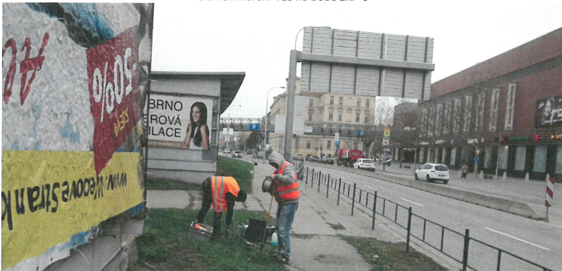
Obr. 3: Měření VES na bodě ZKP-6
