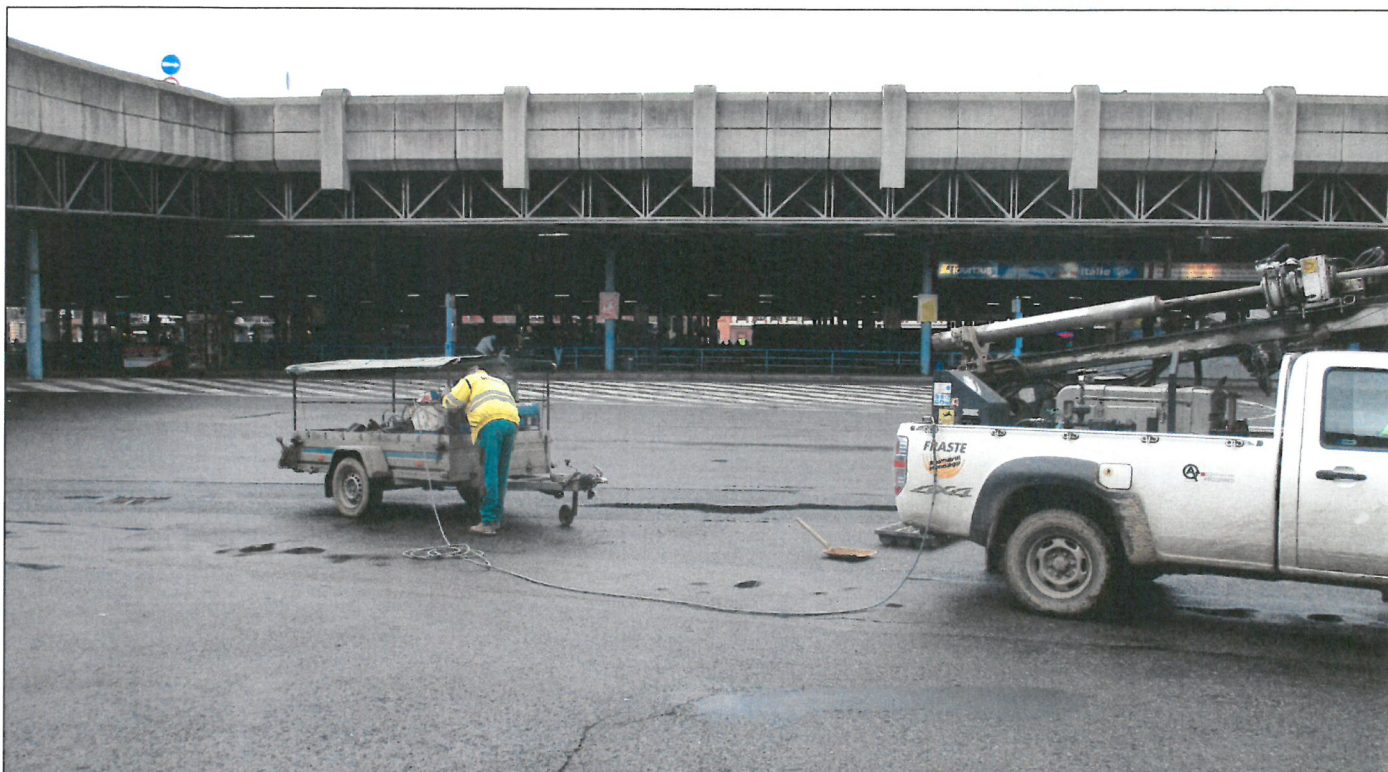
Obr.1: Realizace mělkého návrtu ZV-6 pomocí vrtné soupravy MultiDrill Hyndaga dne 20.11.2017
