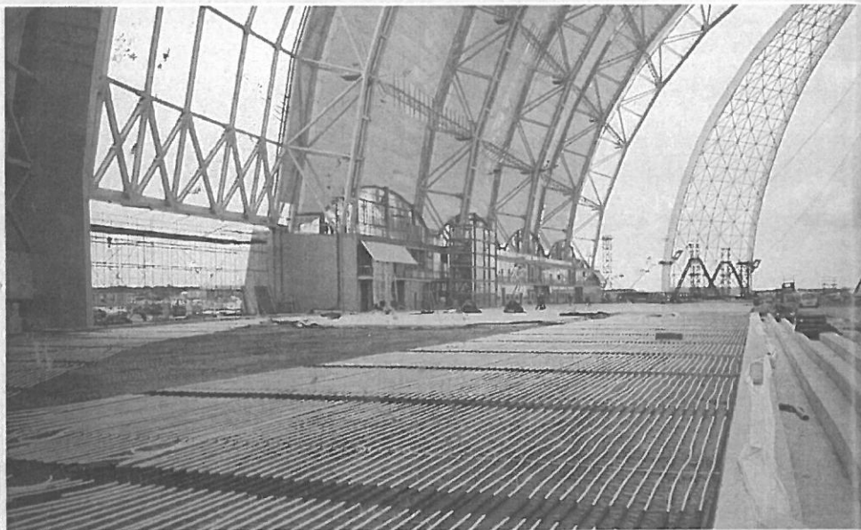
System nosných prvků trubky Roth, Tropical Island, Brandenburg
