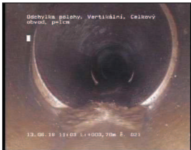
Foto 021 Videopáska: 1/5 Stav LV-- 3,70 m Odchylka polohy, Vertikální, Celkový obvod, Přesazení = 1cm
