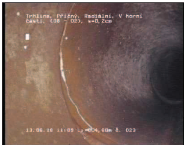
Foto 023 Videopáska: 1/5 Stav RQ-O 4,60 m 8 - 2 Uhr Trhlina, Příčný, Radiální, V horní části, Šířka trhliny = 0,20cm
