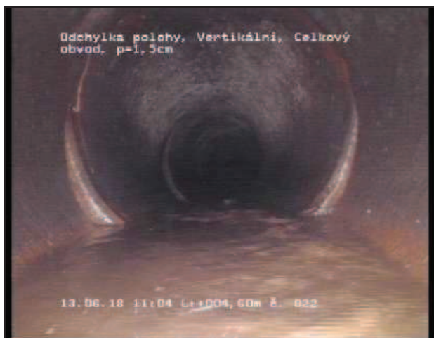
Foto 022 Videopáska: 1/5 Stav LV-- 4,60 m Odchylka polohy, Vertikální, Celkový obvod, Přesazení = 1,50cm
