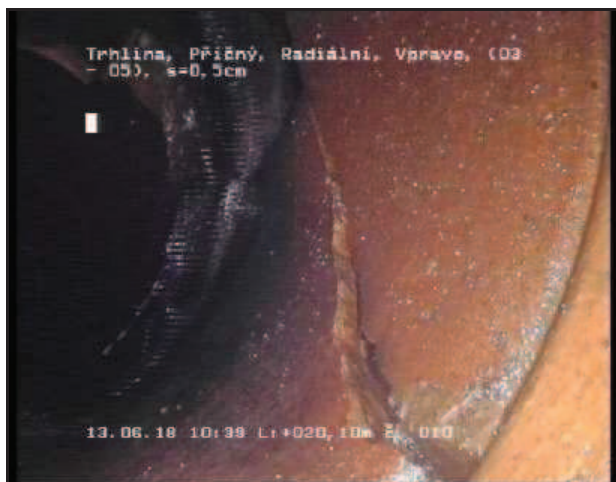
Foto 010 Videopáska: 1/4 Stav RQ-R 20,10 m 3 - 5 Uhr Trhlina, Přičný, Radiální, Vpravo, Šířka trhliny = 0,50cm
