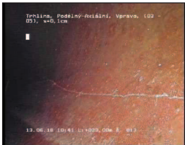
Foto 013 Videopáska: 1/4 Stav RL-R 23,00 m 3 - 5 Uhr Trhlina, Podélný-Axiální, Vpravo, Šířka trhliny = 0,10cm; V délce cca 1m
