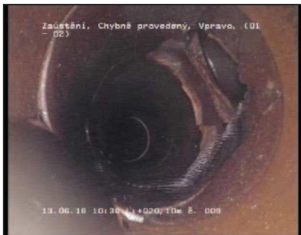
Foto 009 Videopáska: 1/4 Stav SN-R 20,10 m 1 - 2 Uhr Zaústění, Chybně provedený, Vpravo
