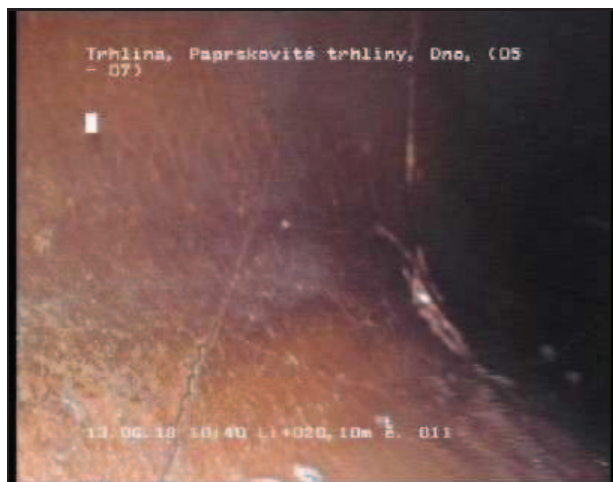
Foto 011 Videopáska: 1/4 Stav RX-U 20,10 m 5 - 7 Uhr Trhlina, Paprskovité trhliny, Dno
