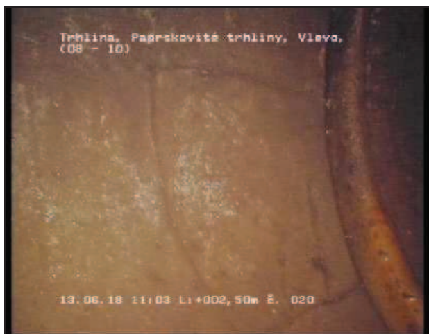
Foto 020 Videopáska: 1/5 Stav RX-L 2,50 m 8 - 10 Uhr Trhlina, Paprskovité trhliny, Vlevo
